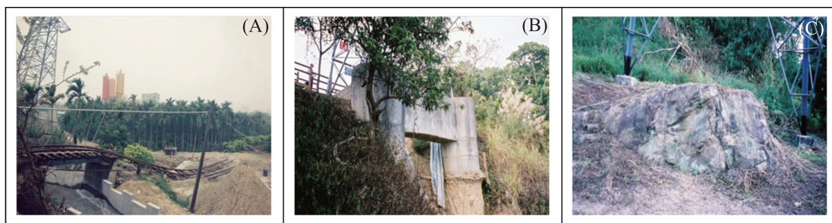
圖5 塔柱易致災區之環境地質現況(A：沿活動斷層之地表破裂造成塔柱傾斜、B：向源侵蝕造成塔基崩失、C：基盤逆向坡之塔柱)
