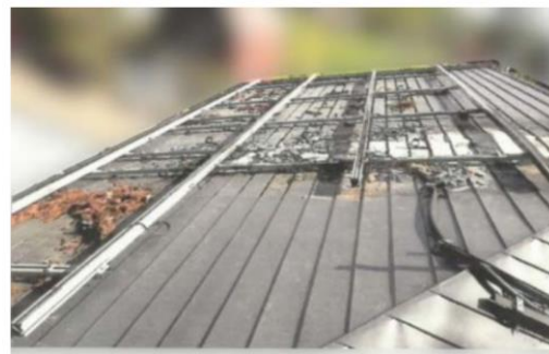
圖2、屋頂損壞狀(右圖為模組撤除後狀況)
