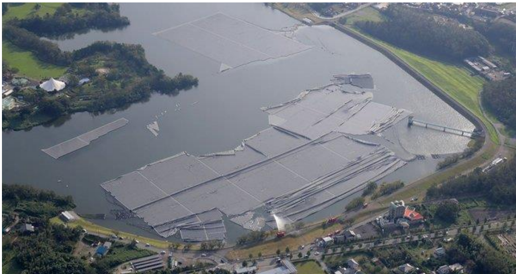
圖7、全日本最大的水上型太陽光電發電廠發生了火災事故
