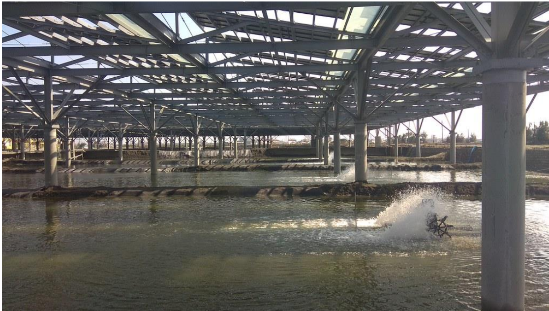
圖 3、立柱式漁電共生案例
