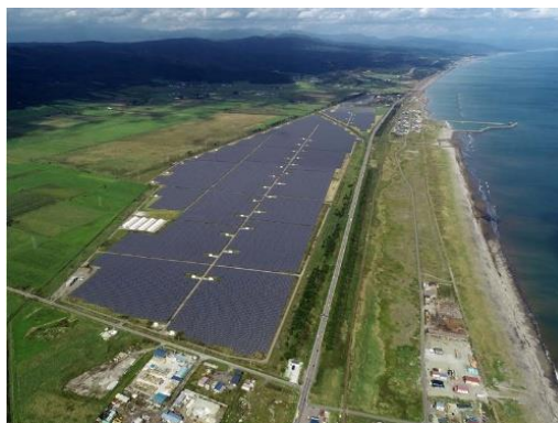
圖六、北海道八雲町，日本最大的結合蓄電池的太陽光電系統(102.3MW)[10]。
