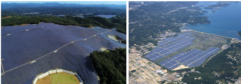
圖一、目前日本位居第一、二名的大規模太陽光電系統，兩場皆超過200MW且位在岡山縣。(左)位於美作市，花費三年完成設置[3]。(右)位於瀨戶內市，原
