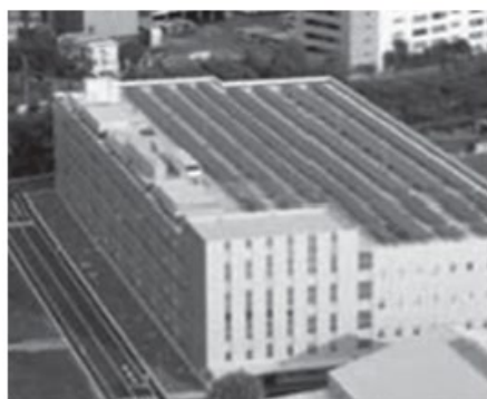
(a)太陽光電發電系統
