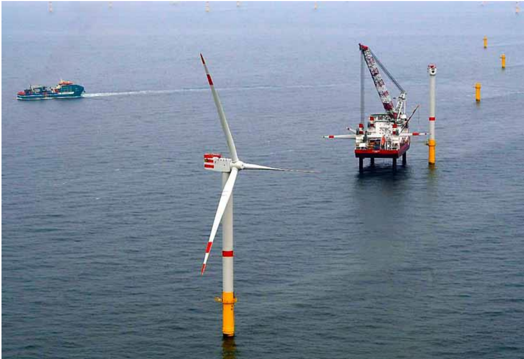
圖 3 Nordsee One 首座風機於 2017 年 3 月完成安裝
