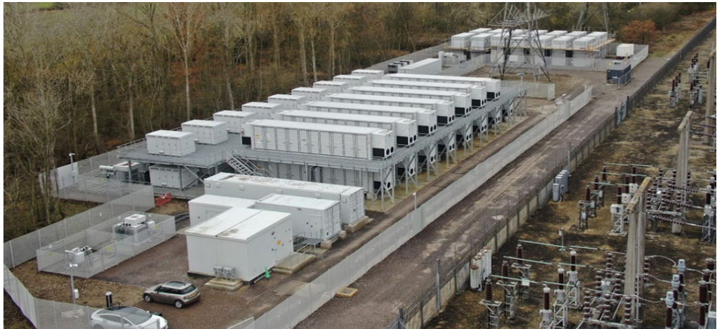
圖 4、英國牛津市世界上最大的鋰鈇混合電池儲能系統測試場域
