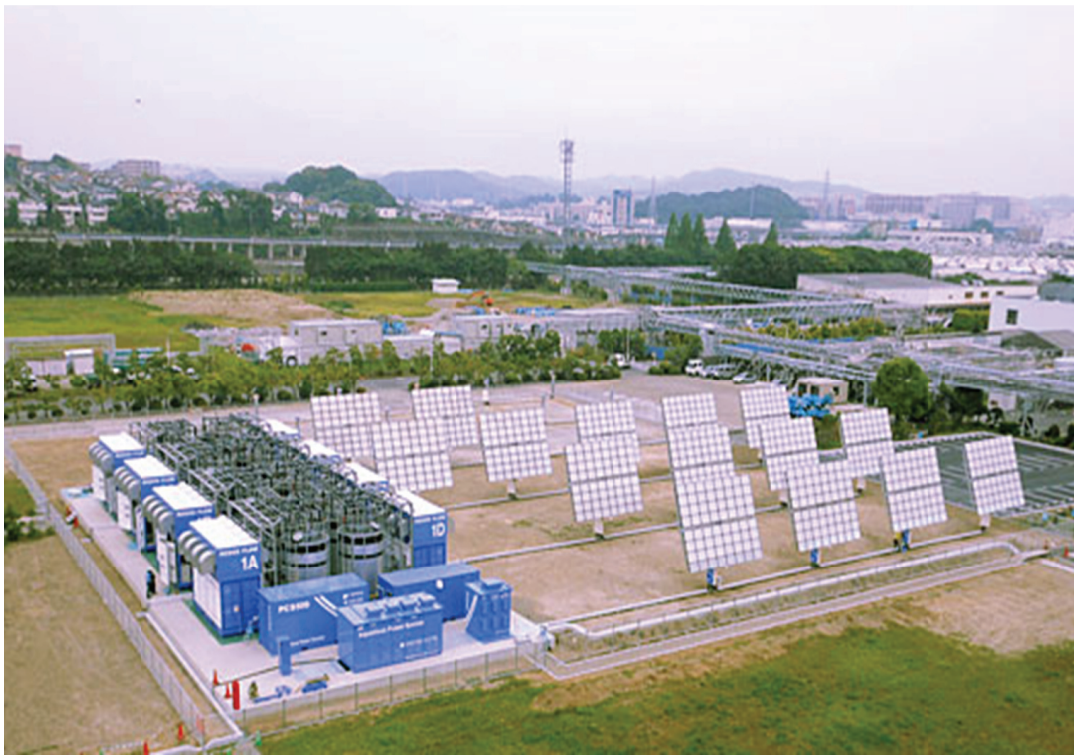
圖6 橫濱百萬瓦級的發電/儲電系統。系統包含1MW/5h的鈎氧化還原液流電池儲電系統(Shibata 2013；Sumitomo Electric 2012 & 2014)
