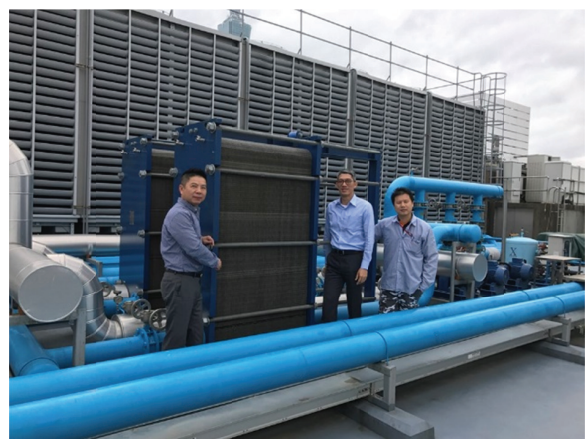
圖27 以低溫冷卻水預冷冰水回水之板式熱交換器(本研究規劃)
