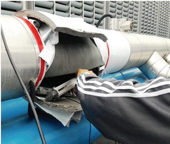
圖28 設置板式熱交換器之冰水回水管BTU監測設施(本研究規劃)
