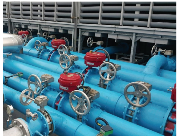
圖26 切割冷卻水路之電動閥(本研究規劃)
