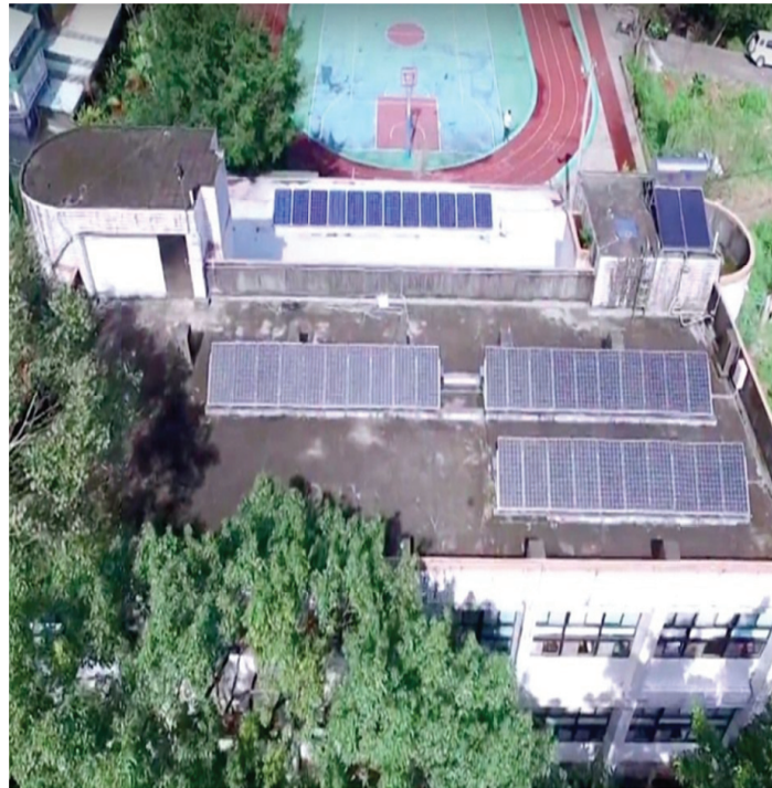
圖2 台電烏來福山部落防災型微電網在福山國小、活動中心屋頂太陽光電發電設備。 圖片來源：經濟日報。
