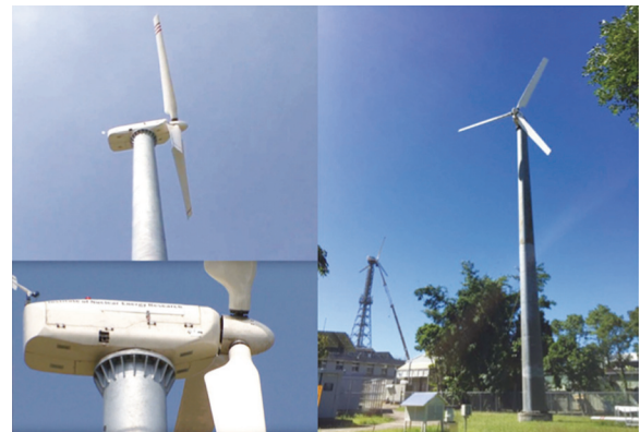
圖1 核研所25 kW水平軸風力發電機(拍攝於核研所)
