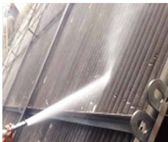
圖3 ACC鰭片上用自來水細清(信鼎營運廠)
