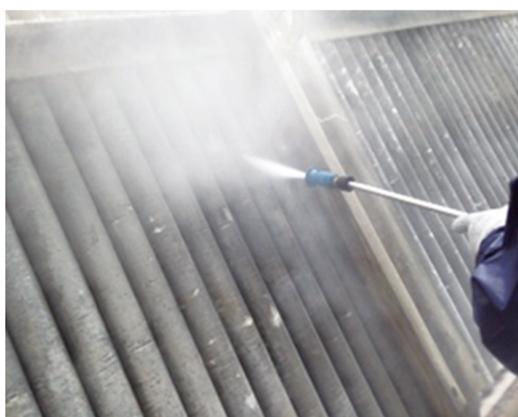
圖2 ACC鰭片上檸檬酸加藥狀況(信鼎營運廠)
