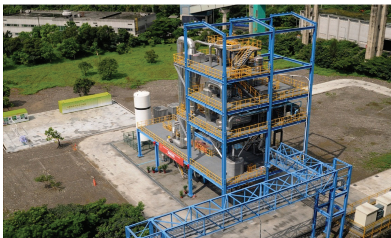
圖6 1.9 MWt鈣迴路捕獲二氧化碳先導型試驗廠
