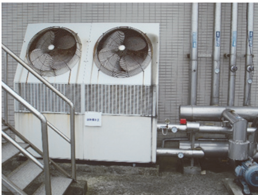
圖2 A案例2台舊氣冷式冰水機
