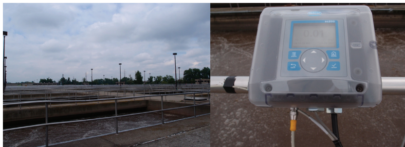
圖3 鳥島(Bird Island)污水處理廠曝氣單元與水質感測器
