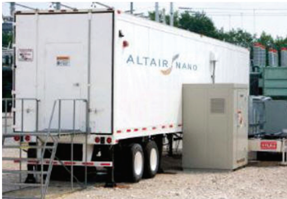
圖1.2-2 1 MW / 250 kWh 鋰離子電池儲電系統 參考資料：Altair Nanotechnologies, 2008
