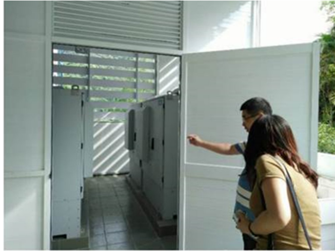
圖十 三峽五寮里電信基地台燃料電池備援電力
