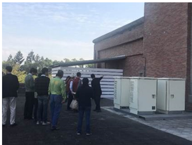
圖九 中正大學基地台燃料電池備援電力
