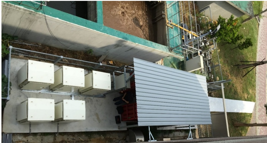
圖八 苗栗大學電信基地台料電池備援電力
