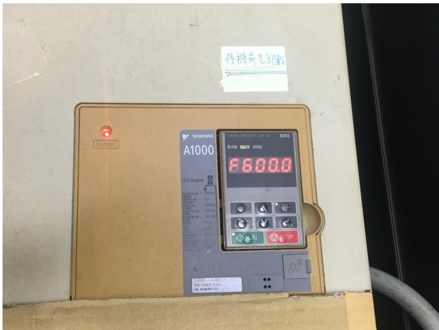
圖22、變頻器面板的輸出頻率設定為600Hz，
