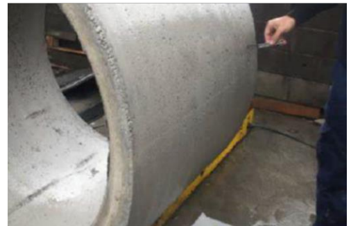
預製混凝土之紐澤西護欄
