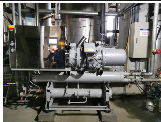
圖：高效率雙效式冷/熱兩用 50RT 熱泵主機
