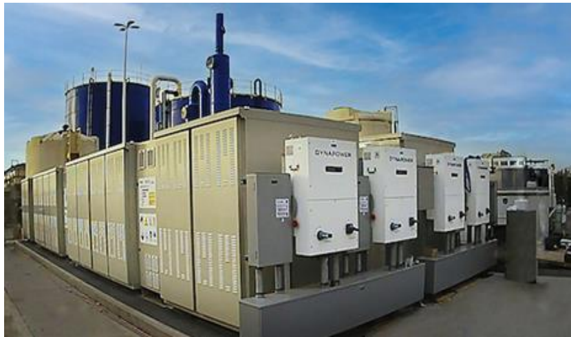
圖5、Redflow 公司在加州 Rialto 生物能源發電廠部署之 Energy Pods 鋅溴電池儲能系統
