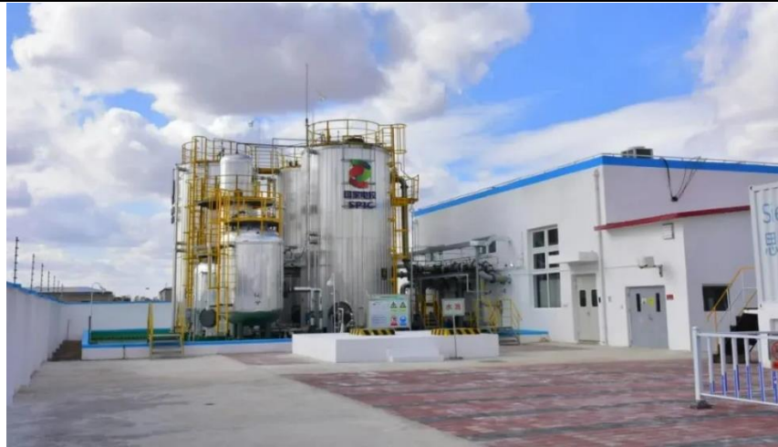
圖6、中國大陸「容和一號」250kW/1.5MWh 的鐵/鉻液流電池示範項目
