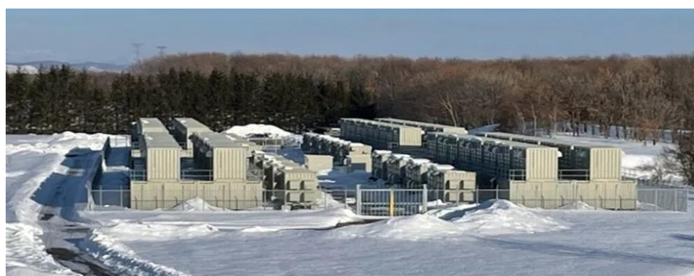
圖 3、日本住友於北海道建置 17 MW/51 MWh 大型儲能蓄電池
