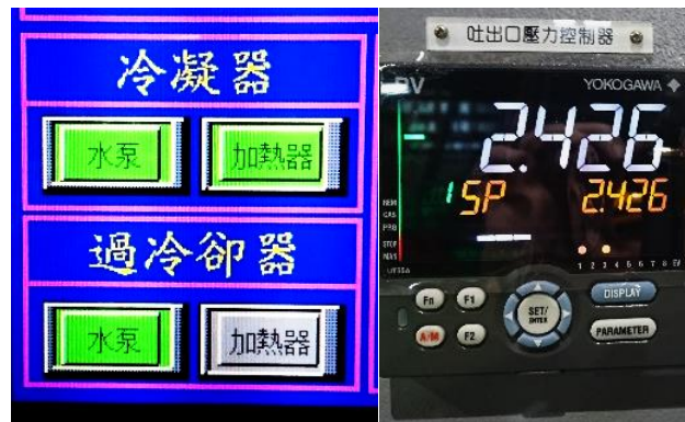
圖 18、冷凝器加熱器與吐出口壓力顯示錶
