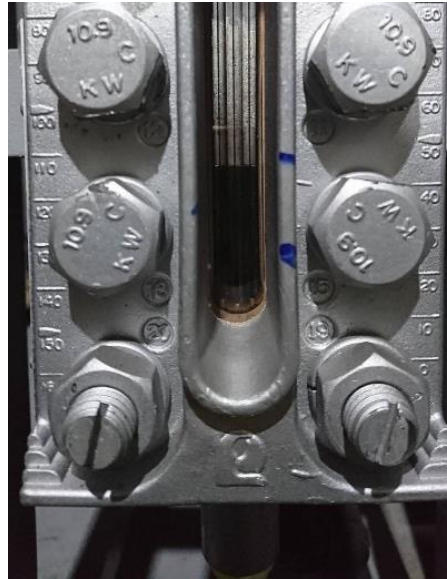
圖 14、冷媒填充後液面高度
