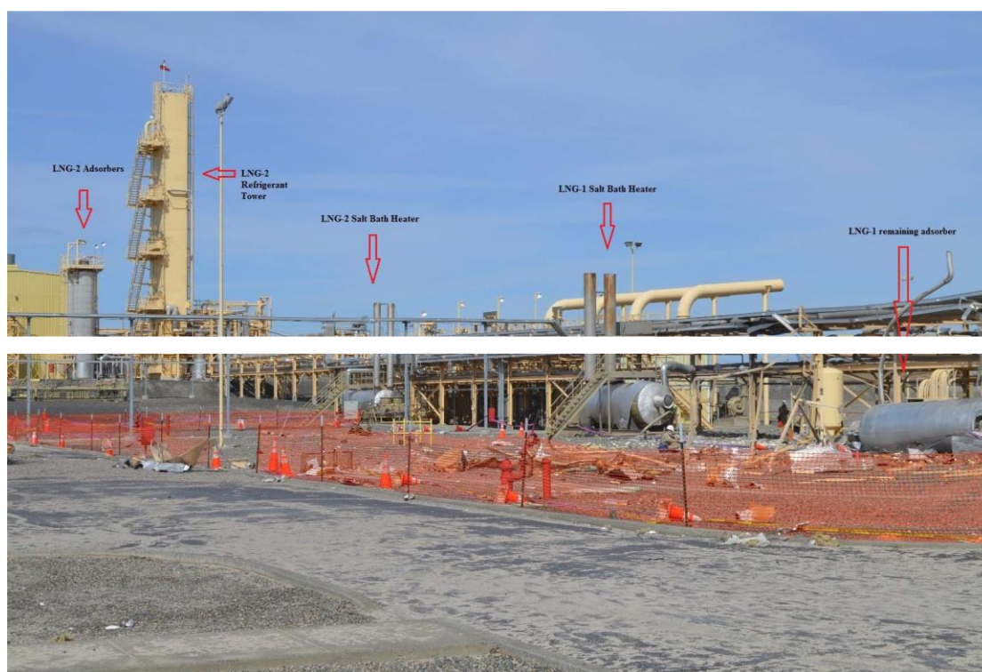
圖 15、LNG-1 和 LNG-2 淨化系統。面向東北。未損壞的 LNG-2 吸附器，冷凍塔和鹽浴加熱器中間左側。
