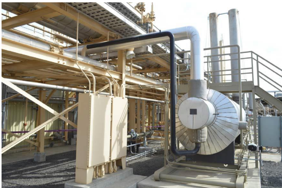
圖 14、與 LNG-1 鹽浴加熱器相同的 LNG-2 鹽浴加熱器。4 英寸進氣管線被塗成黑色。
