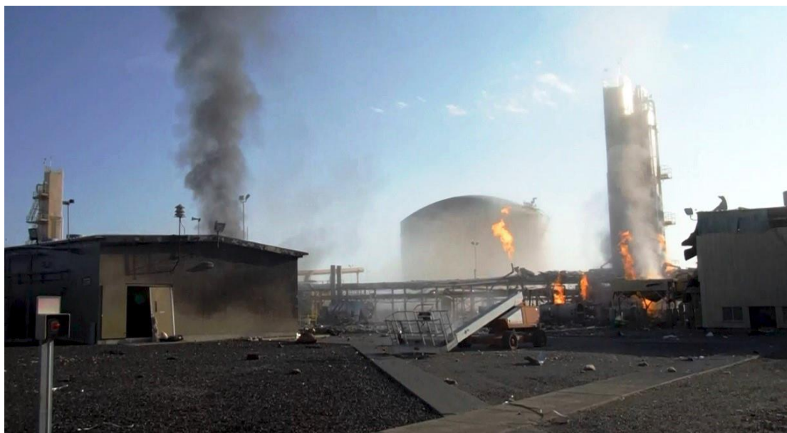
圖 6、控制室(圖中間左側)。建築中心右側 LNG-1 壓縮機，冷卻塔位於壓縮機設施的左側。在失效的吸附器附近，天然氣從切斷的淨化循環管線中燃燒
