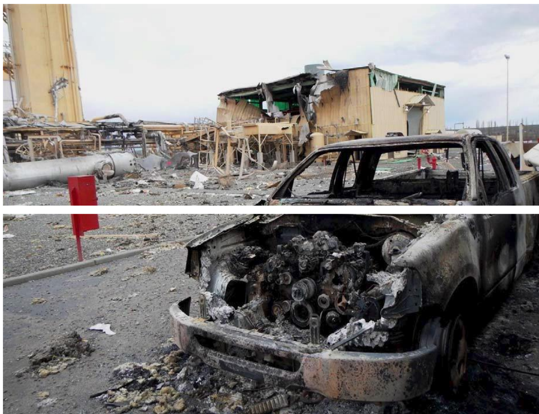
圖 8、從控制室前面向事故現場看到的 SE。其中一個吸附器位於其側面。壓縮機在中後側。左上方冷凍塔。以燒毀的卡車作為參考
