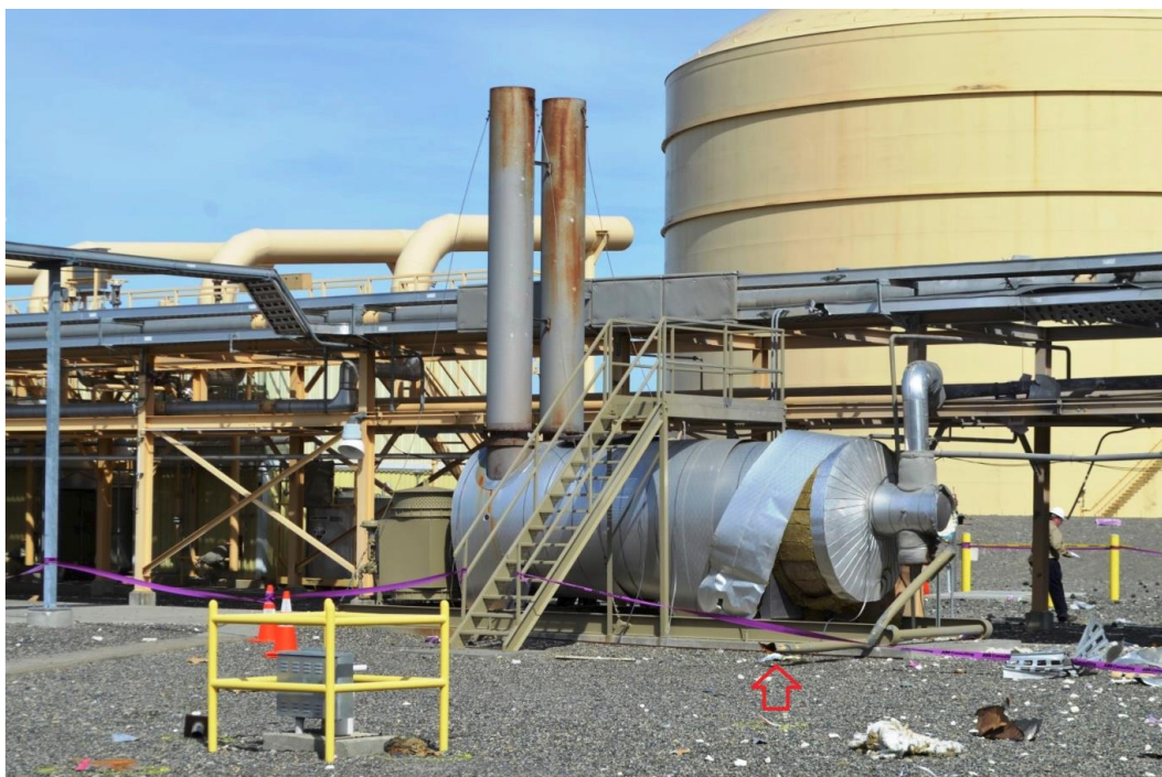
圖 12、LNG-1 鹽浴加熱器自燃。紅色箭頭表示 4 英寸加熱器氣體入口中的故障點。管線向外和向下吹。它通常在加熱器後面的管架上。面向東北。LNG-2 儲罐在其後方
