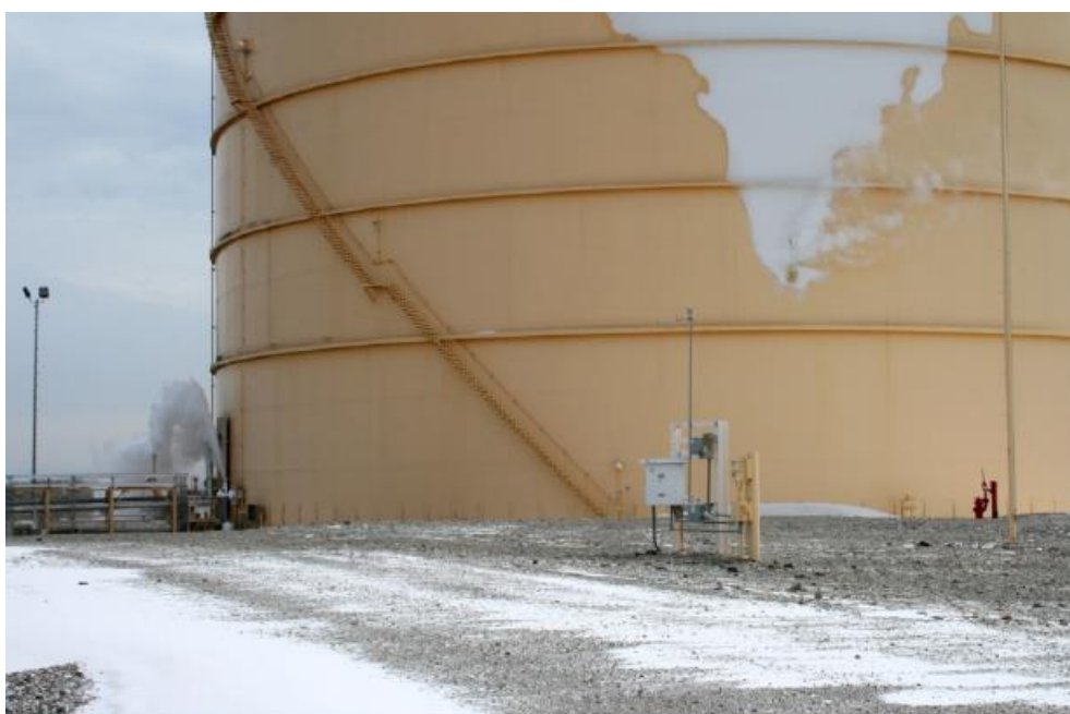
圖 5、面向東方，LNG 1 儲槽外觀圖。洩漏的 0.5 英吋液化天然氣管線位於儲槽左下方，在儲槽外牆有 v 型的冰層形成。地面左下方珍珠岩保溫層
