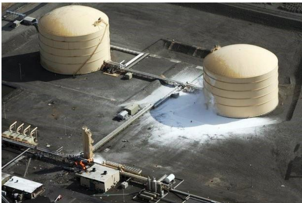
圖 4、失效後不久採取的鳥瞰圖。火還在燃燒。滲透的外部 LNG-1 儲槽的珍珠岩絕緣層洩漏。控制室左下方
