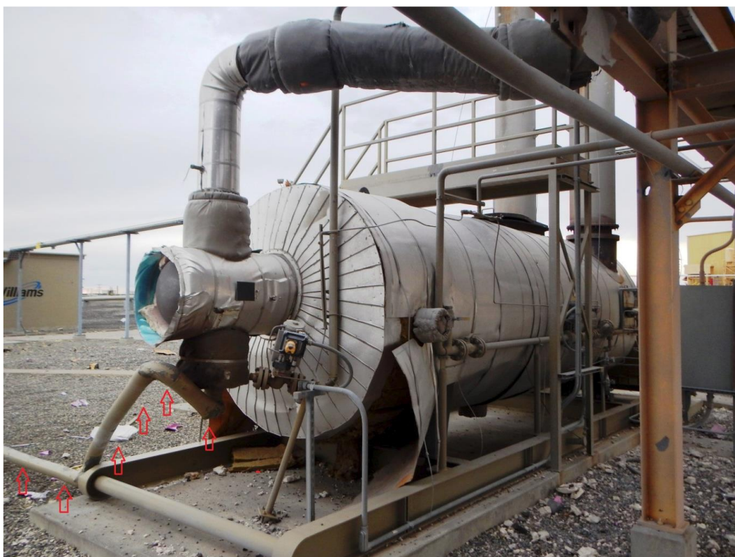
圖 13、鹽浴加熱器的另一個角度。用紅色箭頭表示 4 英寸進氣管，管線被吹到加熱器的左側。面向西北。
