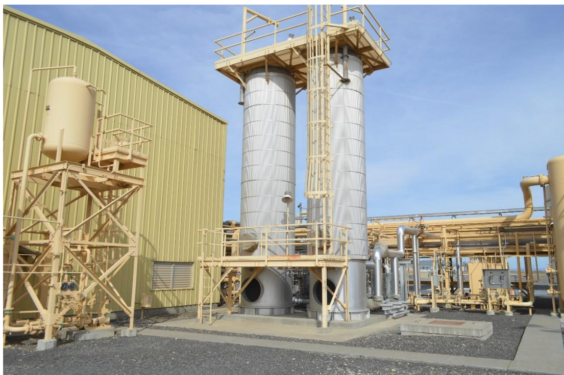
圖 16、未損壞的 LNG-2 吸附器，與事故前的 LNG-1 吸附器相同。
