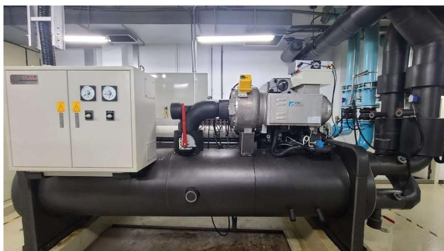
圖 1、國產 1 級能源效率 250 RT 級磁浮離心式冰水機
