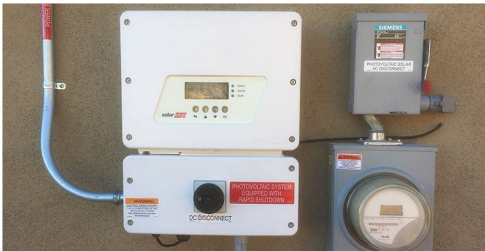
圖 7、SolarEdge 快速關斷系統[11]
